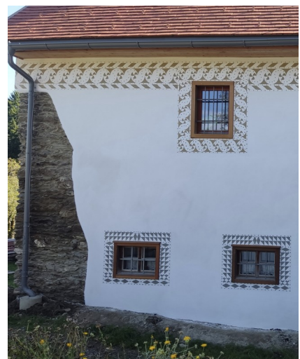
Schöne Steinmauer sichtbar
